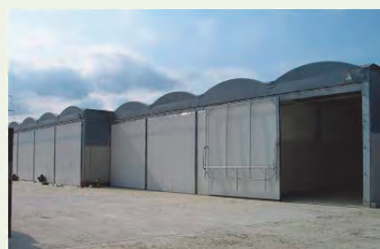
Κλειστό σύστημα κομποστοποίησης σε σειράδια με εξαναγκασμένο αερισμό και μηχανική ανάδευση. Τα βιοαπόβλητα τοποθετούνται μέσα σε οριζόντια κανάλια.
